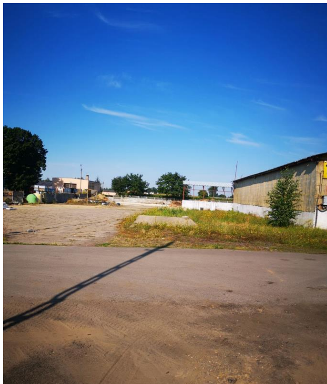
Rysunek 11. Widok na centralną część działki inwestycji
