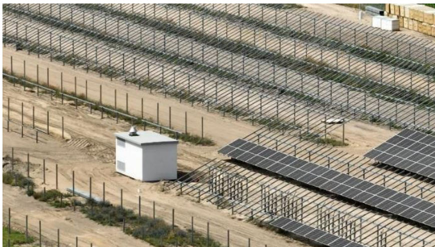
Fotografia 1 Budowa elektrowni fotowoltaicznej
