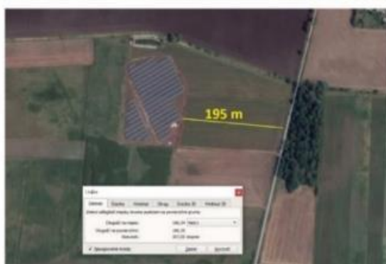
Fotografia 17 Fotografia istniejącej elektrowni w krajobrazie rolnym z odległości około 200 metrów
