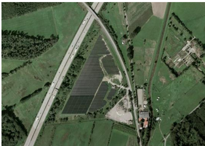
Fotografia 7 Elektrownia fotowoltaiczna w Iffezheim (źródło: Google maps)
