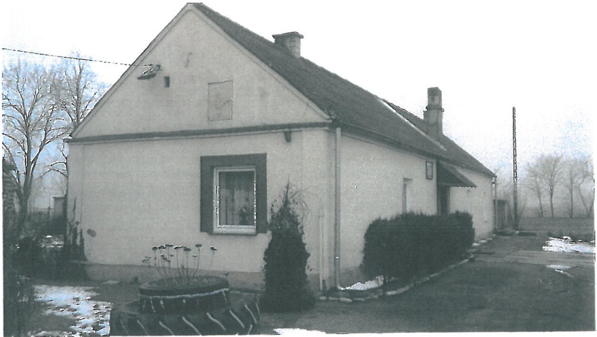
Zdj. Nr 1 Budynek świetlicy wiejskiej w Lucynowie, gmina Ostrowite – widok ogólny elewacji frontowej i szczytu południowo – wschodniego
