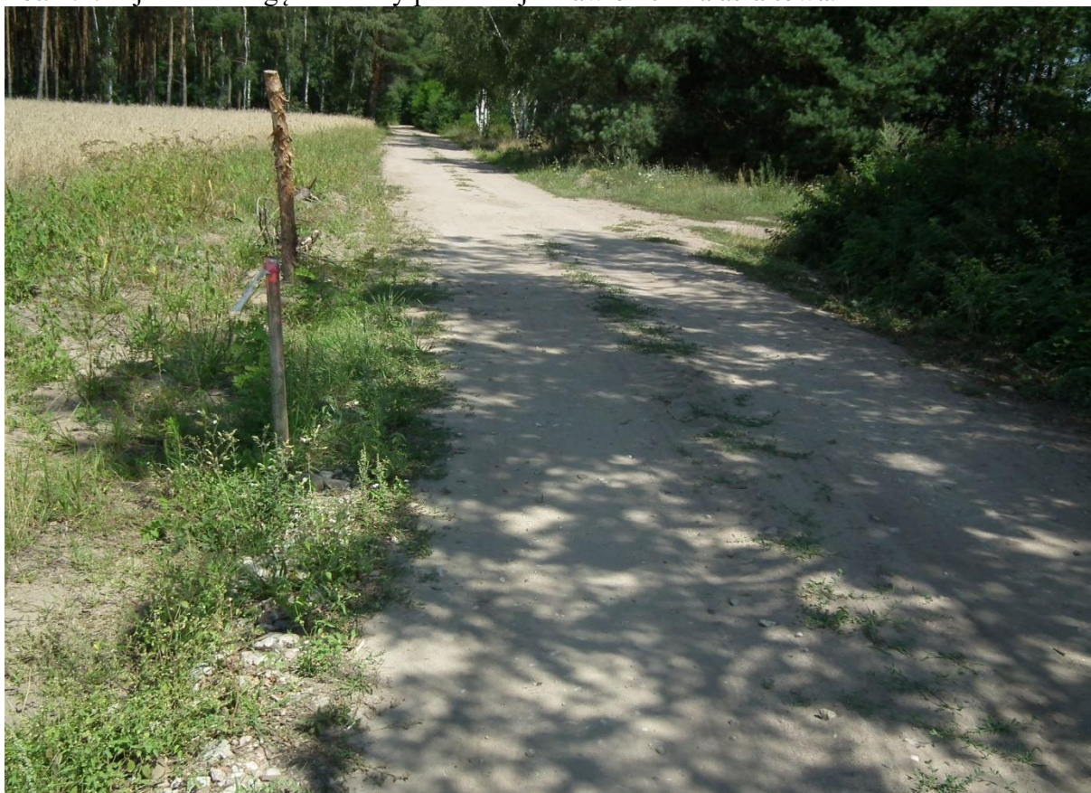
Fot.2.2. Wjazd na odcinek drogi od strony południowej – nawierzchnia gruntowa.
