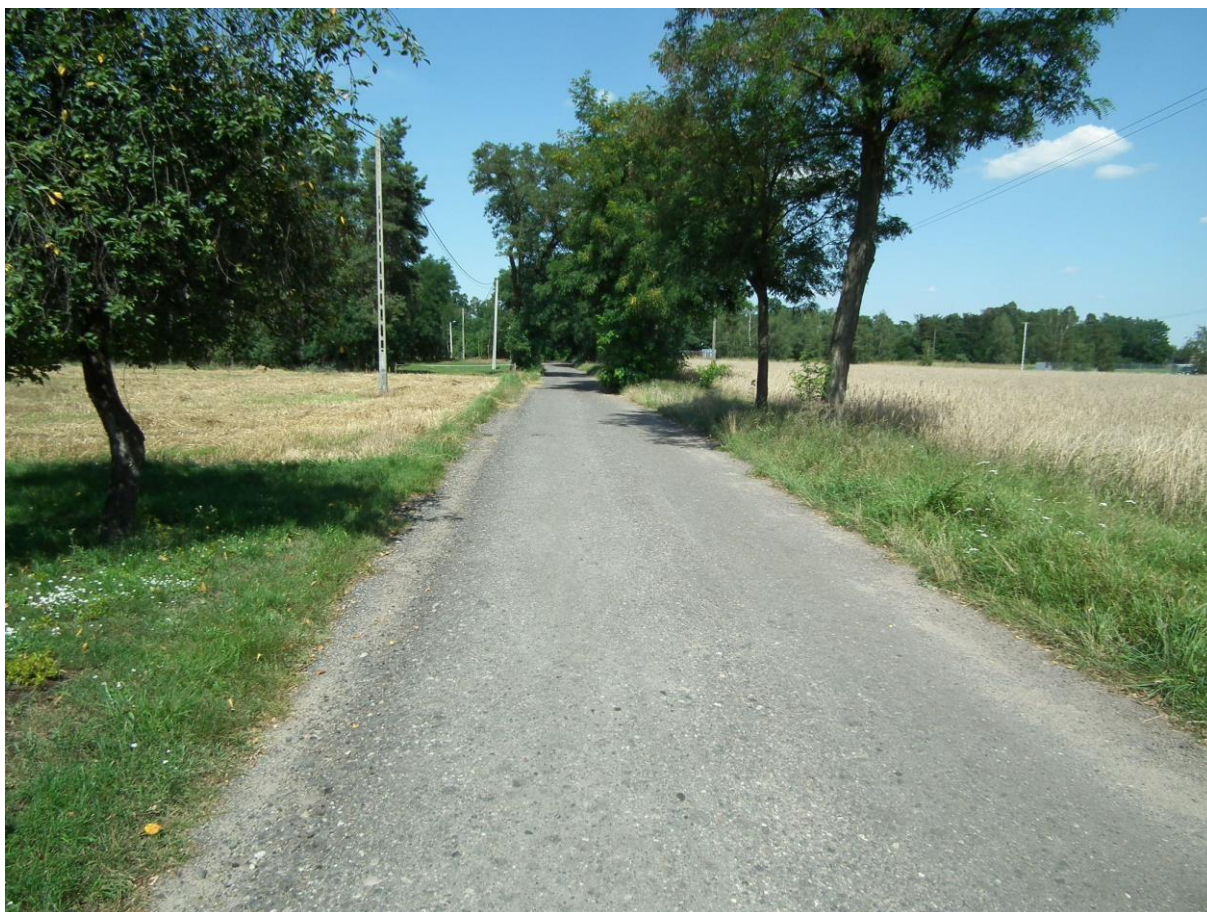
Fot. 2.5. Północno - zachodni fragment drogi z drzewami (do usunięcia).
