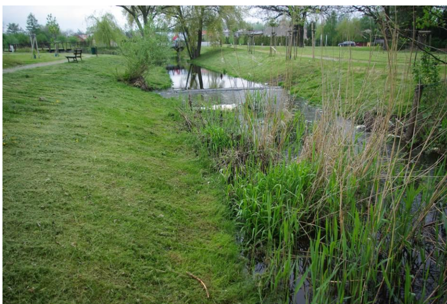
Fot. 2. Zdjęcie poglądowe lokalizacji budowli km 4+408 Strugi Biskupiej
