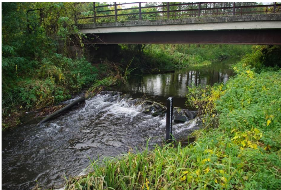
Fot. 1. Zdjęcie poglądowe lokalizacji budowli km 1+915 Strugi Biskupiej
